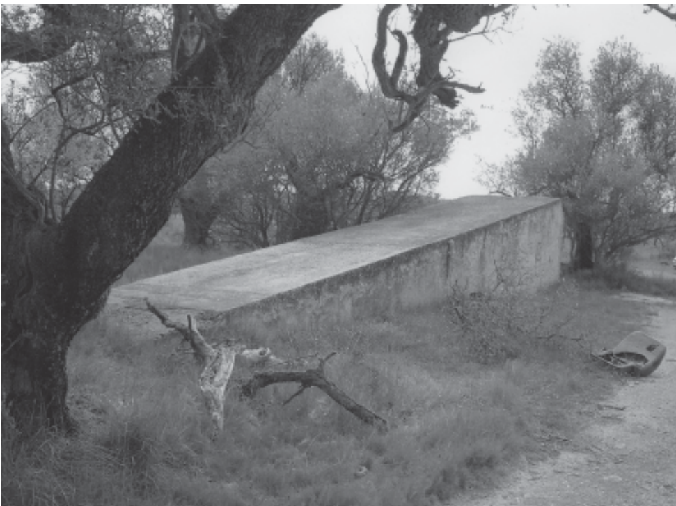
Boca entrada refugio
